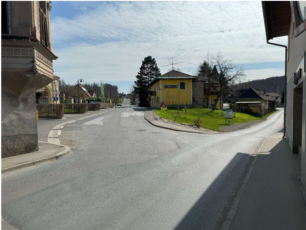
Abbildung 15 - Fehlende Querungsmöglichkeit für den Fußverkehr (© Triagonal)
